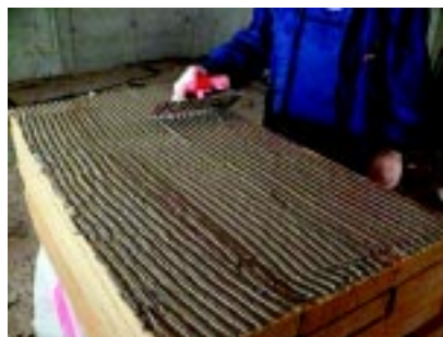
Rozprowadzanie zaprawy packą zębatą
