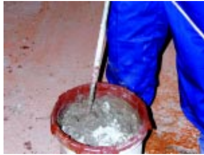
Przygotowanie zaprawy klejowej
