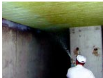
Przyklejone płyty gotowe do malowania
